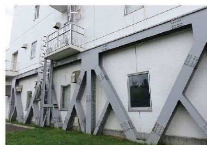
揚水施設の耐震化（外部補強）
