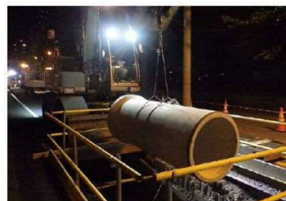
管路の耐震化（管の入れ替え）
