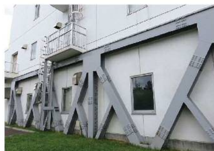
水再生プラザ・ポンプ場の外部補強による耐震化
