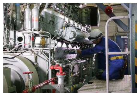
【処理施設】設備の修繕
