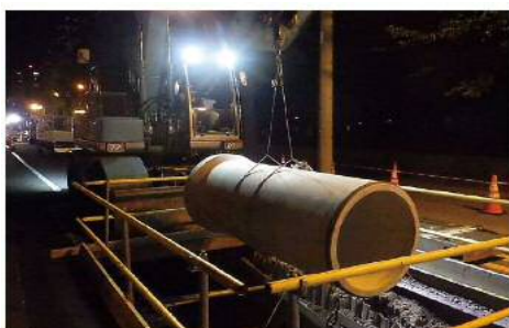
管路の入れ替えによる耐震化
