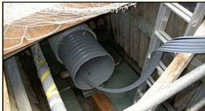
管更生工法による老朽管の改築
