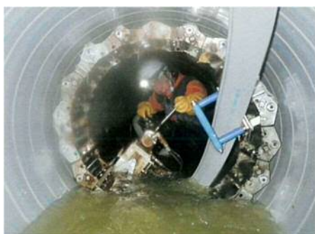
○管路の耐震化工事
