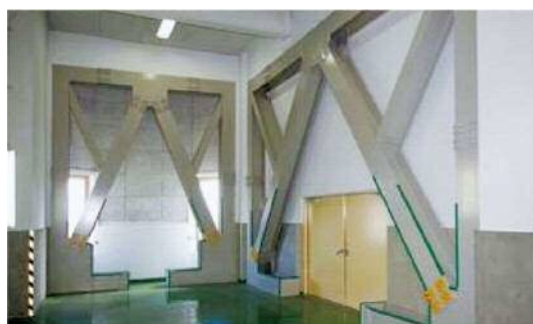
○水再生プラザの耐震補強
