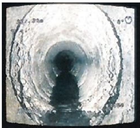
【管更生工法による管路の改築】
