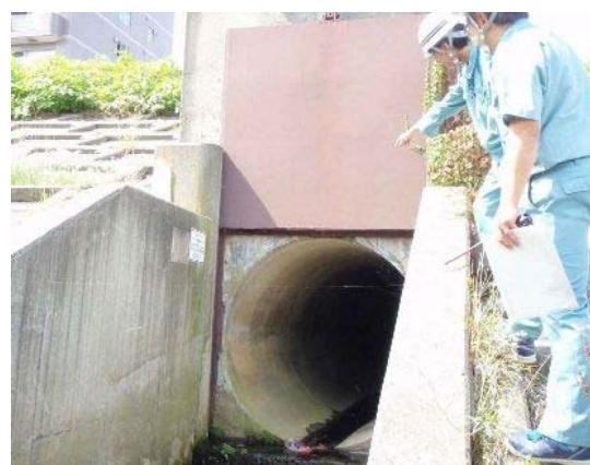
災害対応訓練(施設の緊急点検)
