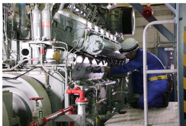
処理施設の設備の調査
