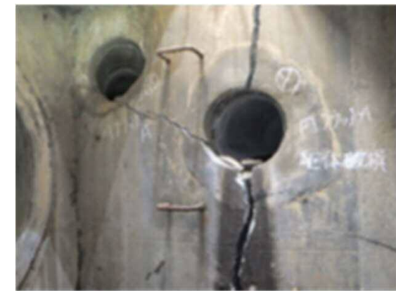
①管のつなぎ目にズレが発生 ②管のたるみにより滞水が発生 ③マンホールに亀裂が発生
