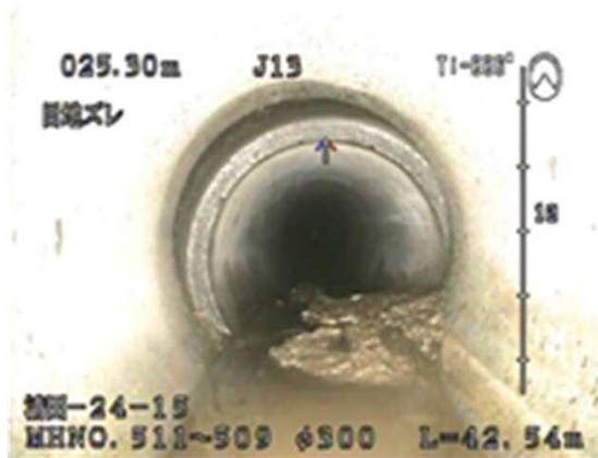
①管のつなぎ目にズレが発生 ②管のたるみにより滞水が発生 ③マンホールに亀裂が発生
