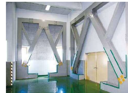
耐震補強の状況
