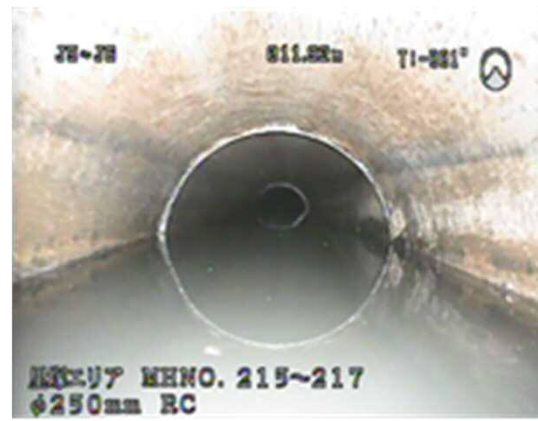
①管のつなぎ目にズレが発生 ②管のたるみにより滞水が発生 ③マンホールに亀裂が発生
