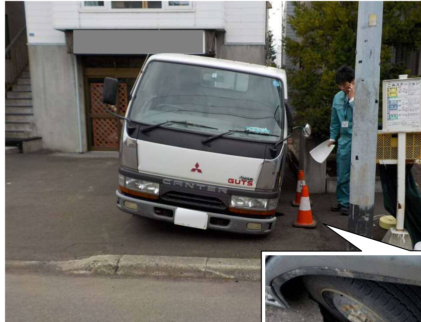
札幌市で発生した道路陥没
