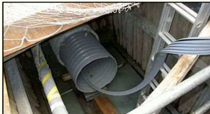
管更生工法による老朽管の改築
