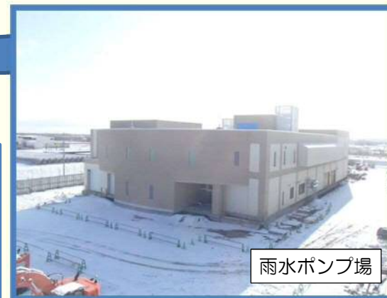
東雁来雨水ポンプ場（写真右）と 東雁来雨水拡充管（写真左）の施工状況
