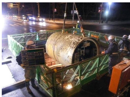
都心部の管路耐震化工事
