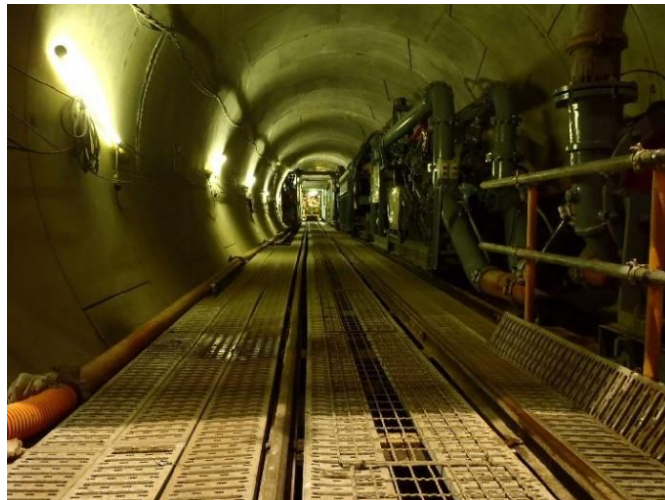
【豊平川雨水貯留管建設中の様子】
