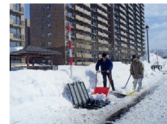
流雪溝への投雪状況
