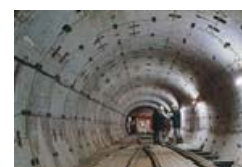
貯留管内部（既設）
