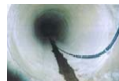
管内に敷設された光ファイバーケーブル
