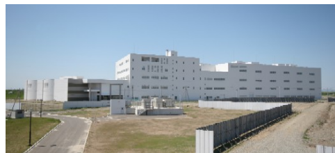
東部スラッジセンター概観
