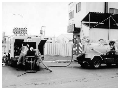
高圧洗浄車と揚泥車による下水管の清掃
