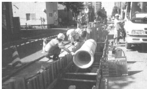
老朽化が著しい管路を、新しい管路に取り替えています。
