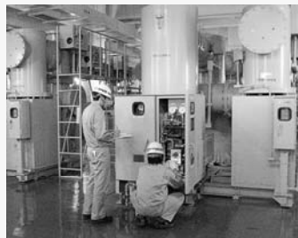
設備の点検・整備
