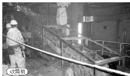
老朽化したコンベア設備を、障害が生じる前に取り替えました。
