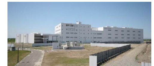
東部スラッジセンターの外観
