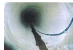
管内に敷設された光ファイバーケーブル
