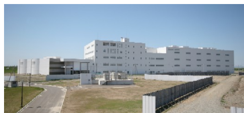
東部スラッジセンター概観
