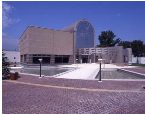
【下水道事業の広報施設である札幌市下水道科学館】
