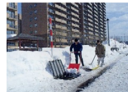
流雪溝への投雪状況
