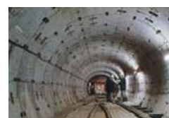
貯留管内部（既設）
