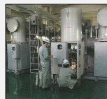
設備点検・検査
