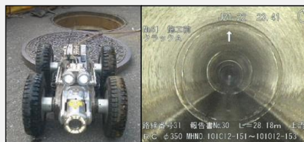
管路調査：テレビカメラ調査
