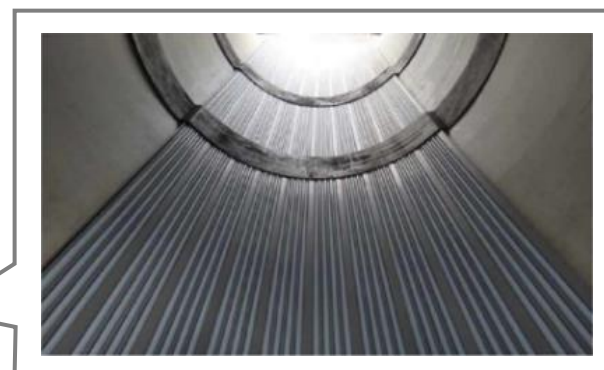
【下水道管内の写真】
