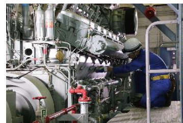
点検・調査と修繕
