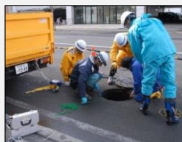
管路点検：目視
