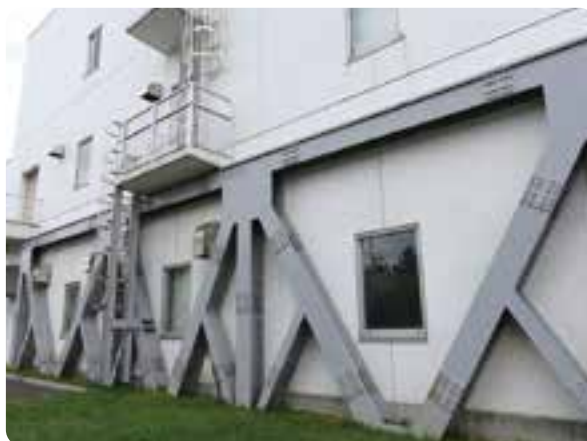
揚水施設の耐震化(外部補強)
