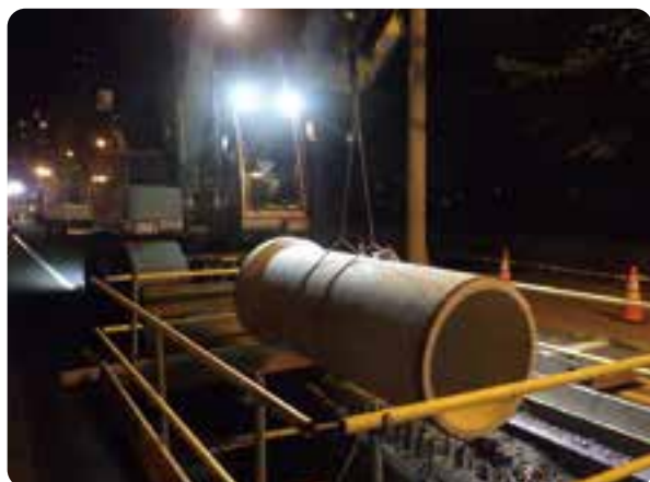
管路の耐震化(管の入れ替え)
