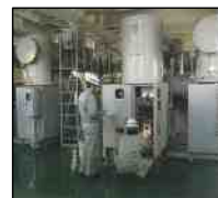
（設備点検・検査）
