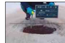
断熱蓋設置前
