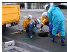
（管路点検：目視）
