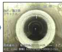
（管路修繕：部分内面修繕）
