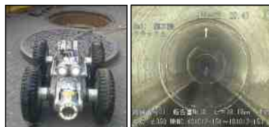
（管路調査：テレビカメラ調査）
