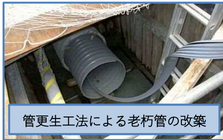
昭和初期に整備した下水管（老朽管）
