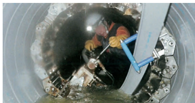
管路の耐震化工事の様子
