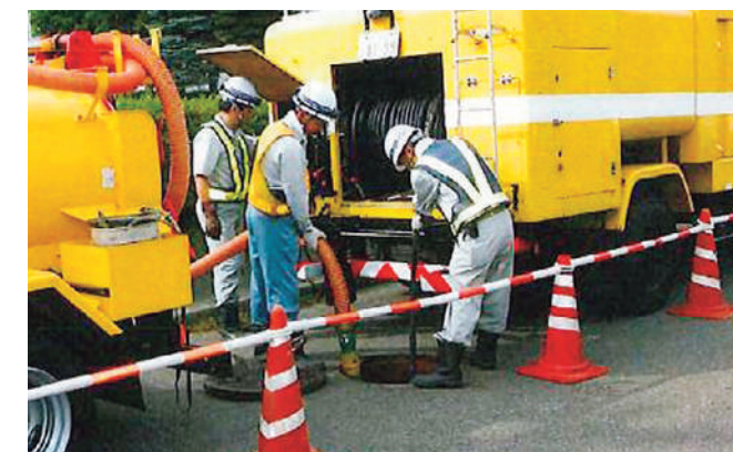
緊急措置訓練（管路清掃）
