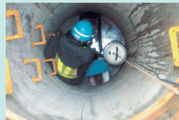
管内清掃作業の様子
