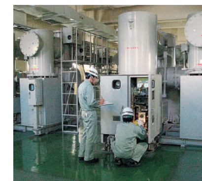
設備の点検・整備
