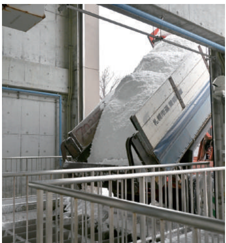
伏古川融雪管
