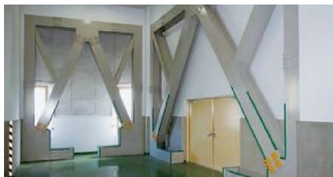
水再生プラザの耐震補強状況
