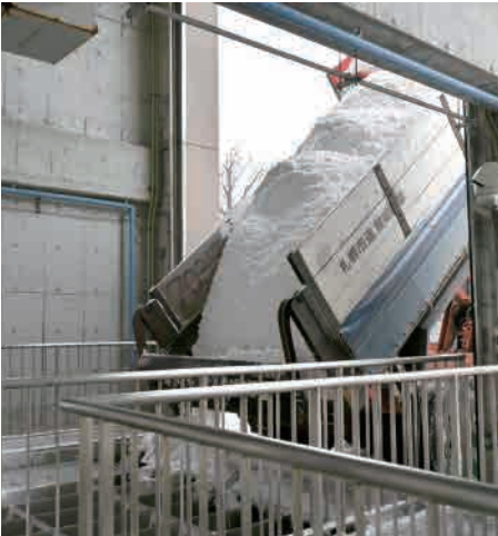
伏古川融雪管
