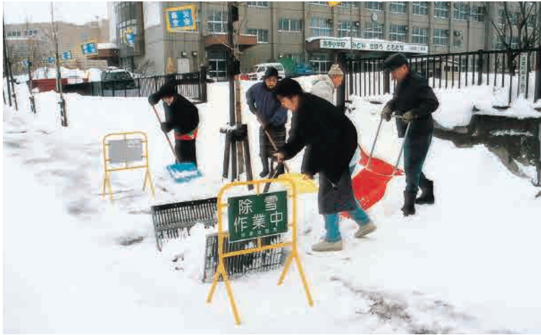
流雪溝投雪状況
