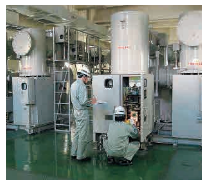
設備の点検・整備
