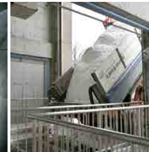
伏古川融雪管
