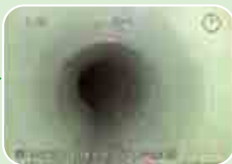
内側に新しい管を作ったようす
