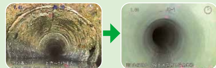
古い管のようす 内側に新しい管を作ったようす
