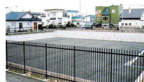
宅地開発時に、雨水貯留池（一時的に雨を貯める施設）を整備するよう義務付けています。
