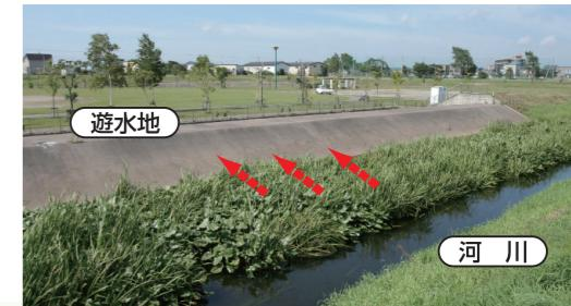
大雨により河川の水位が上昇したときに、河川の水を一時的に貯める施設です。普段はグラウンドなどに利用されています。
