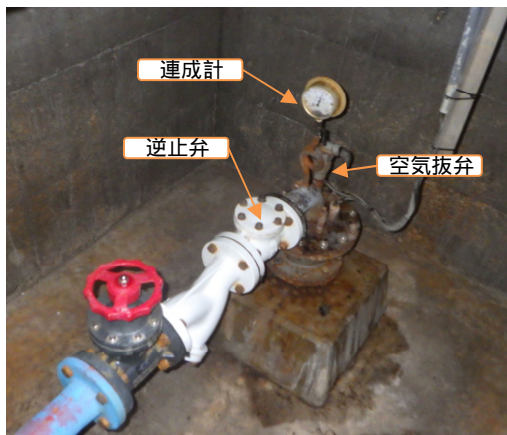
1号井戸ピット内現況写真
