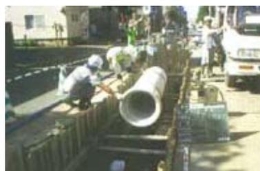
傷みが激しい管を新しいものに取替えます。
