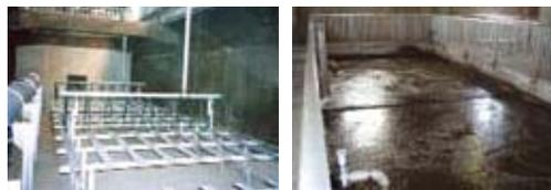
小さな気泡を発生させることにより、下水中に酸素が溶けやすくなるため、送風量が抑えられ、電力使用量を削減することができます。
