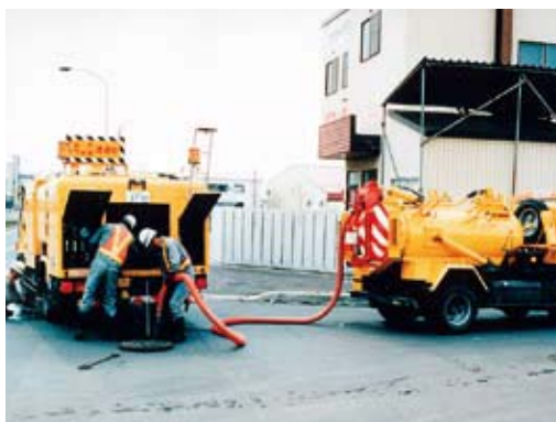
高圧洗浄車と揚泥車による下水道管の清掃
