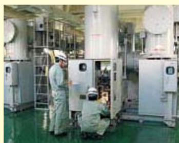
設備の点検・整備
