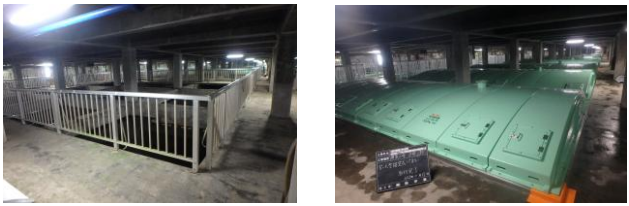
施工前 水再生プラザの覆蓋 施工後
