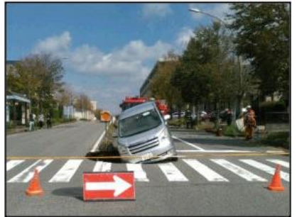
管路施設に起因した道路陥没事故(出典:国土交通省)
