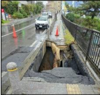
管路施設に起因した道路陥没事故(出典:国土交通省)
