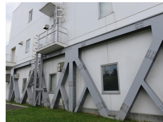
管理棟の耐震化(鉄骨ブレース)
