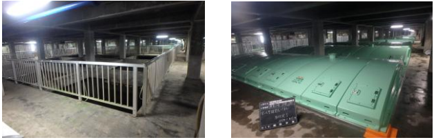
施工前 水再生プラザの覆蓋 施工後
