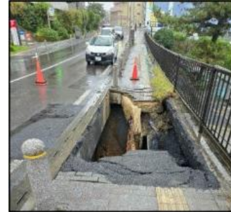
管路施設に起因した道路陥没事故(出典:国土交通省)
