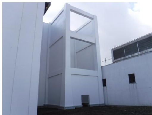
揚水施設の耐震化(フレーム補強)
