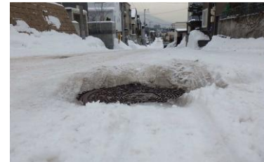
下水道マンホールによる積雪時の段差状況
