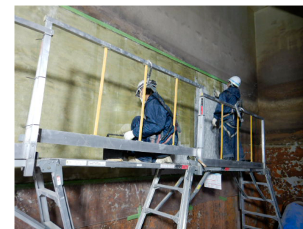
水槽の防食塗装の修繕
