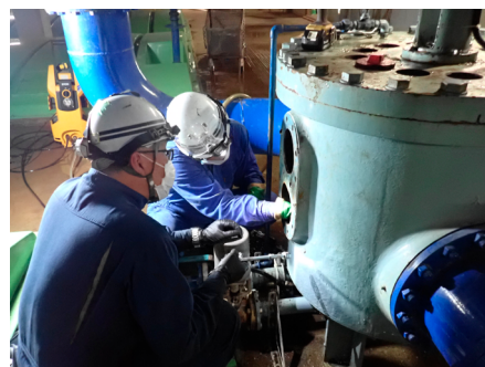
機械設備の清掃
