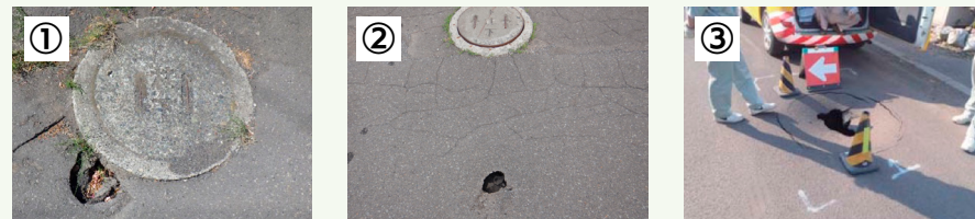
取付管による道路陥没のイメージ
