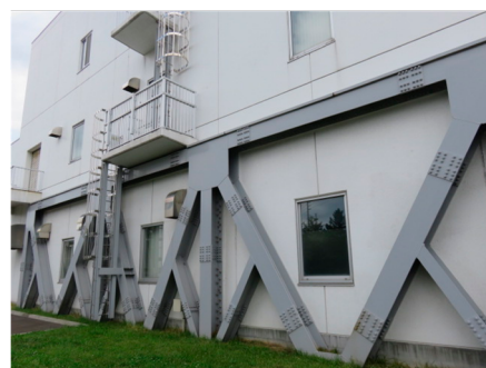
管理棟の耐震化（鉄骨ブレース）
