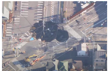
埼玉県の道路陥没事故の状況 （出典：国土交通省）
