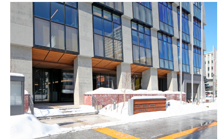
冷暖房設備やロードヒーティングに下水熱を活用した中央区複合庁舎
