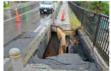
管路施設に起因した道路陥没事故（出典：国土交通省）
