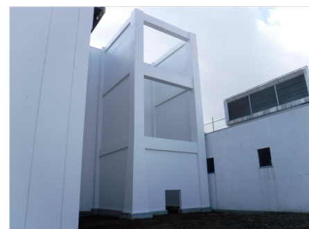
揚水施設の耐震化（フレーム補強）
