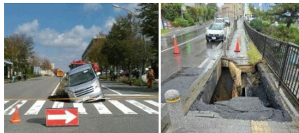
管路施設に起因した道路陥没事故(出典:国土交通省)
