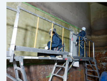
水槽の防食塗装の修繕
