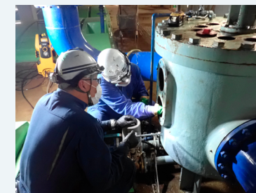
機械設備の清掃
