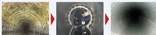
改築前 改築中 改築後 内面が腐食した管路の改築イメージ（管更生工法）
