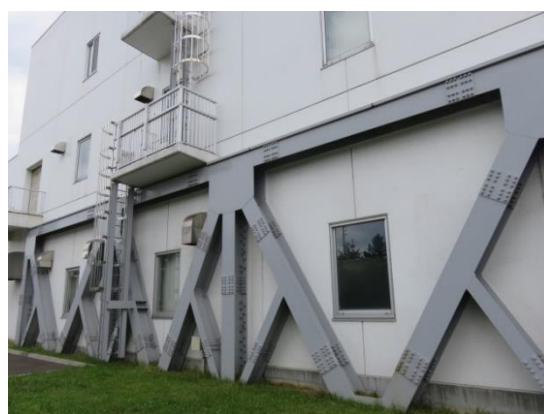
揚水施設の耐震化（外部補強）
