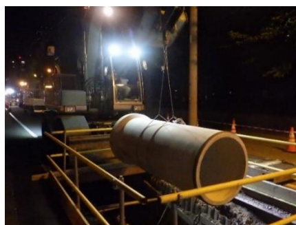
管路の耐震化（管路の入れ替え）
