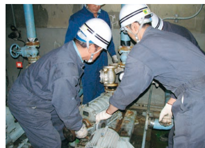
処理施設の保守点検
