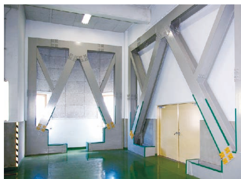
水再生プラザの耐震化
