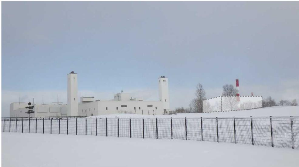
煙突高40m（煙突が東側に移動するが、煙突高は現状よりも低くなるため、影響は小さい）
