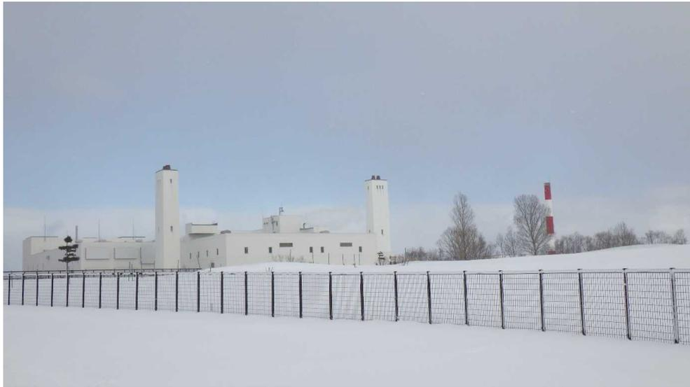
煙突高30m（煙突が東側に移動するが、煙突高は現状よりも低くなるため、影響は小さい）
