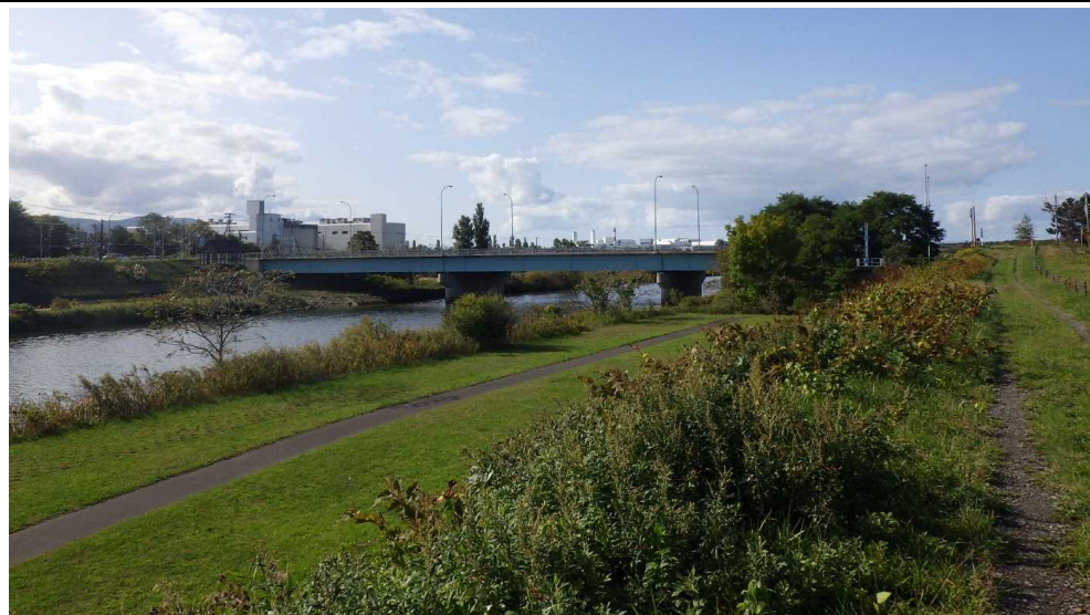
⑦新川緑地（第一新川橋）
