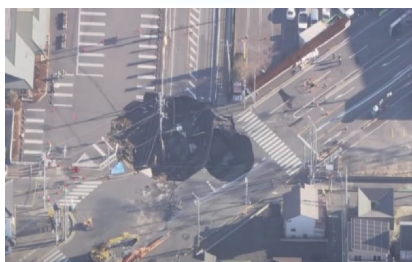
埼玉県の道路陥没事故(出典:国土交通省)
