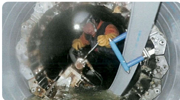
管路の耐震化工事の様子
