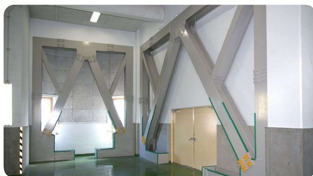
水再生プラザの耐震化
