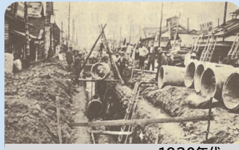
1920年代 管を埋める工事の様子
