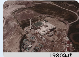
1980年代 汚泥処理施設(西部スラッジセンター)建設の様子
