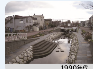
1990年代 “高度処理水”を活用した枯渇した河川のせせらぎ回復(安春川)
