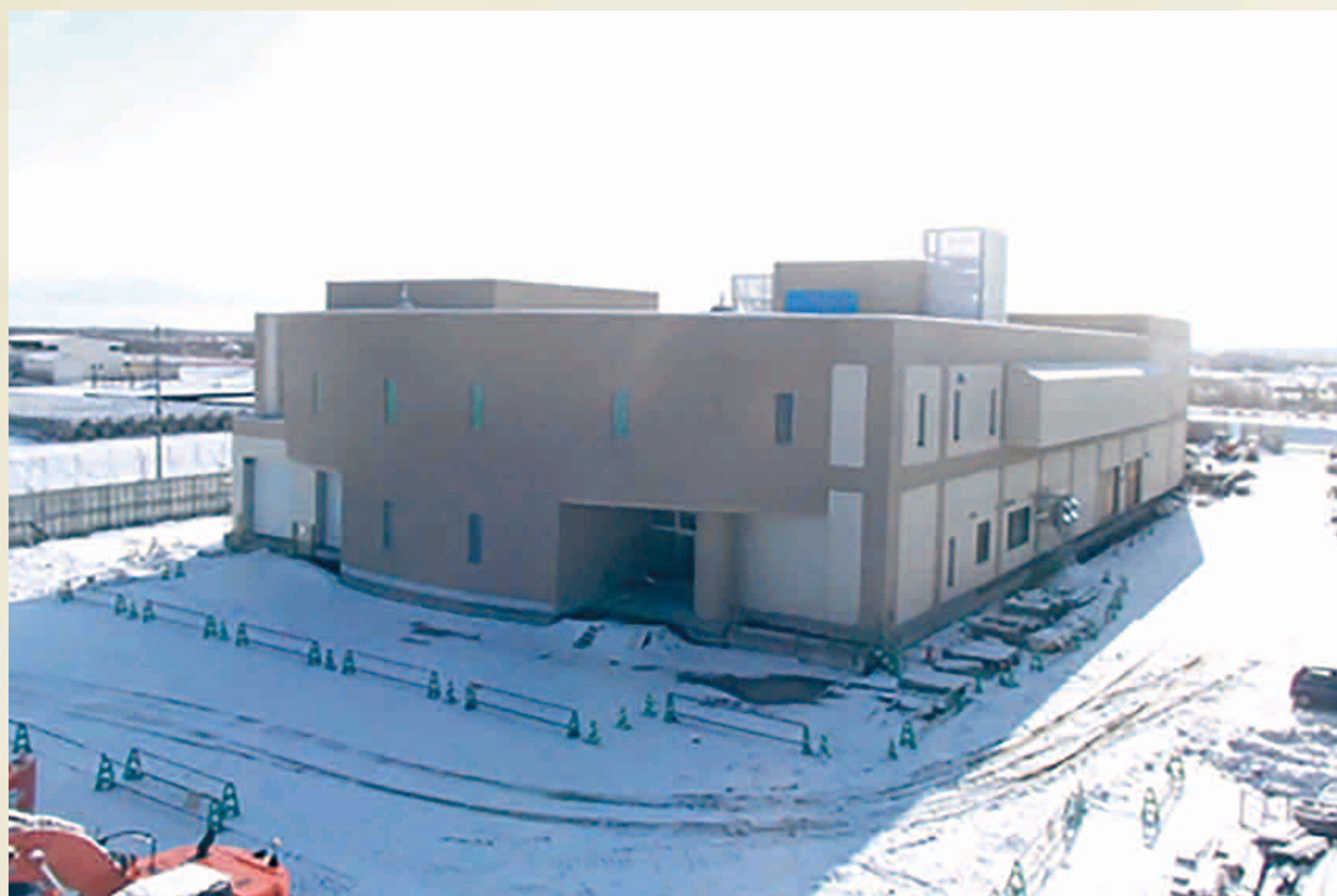
東雁来雨水ポンプ場 運転開始(2018年) 現在の16か所のポンプ場体制へ
