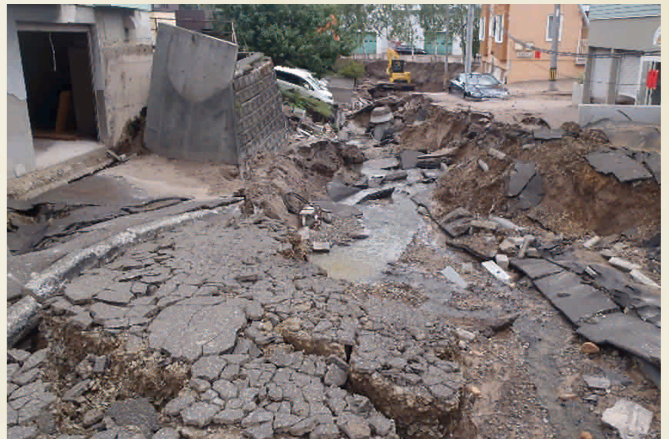
ほっかいどう いぶりとうぶ じしん ひさいじょうきょう ねん 北海道胆振東部地震での被災状況(2019年) えきじょうか ふじょうとう かんろひがい 液状化によるマンホール浮上等の管路被害
