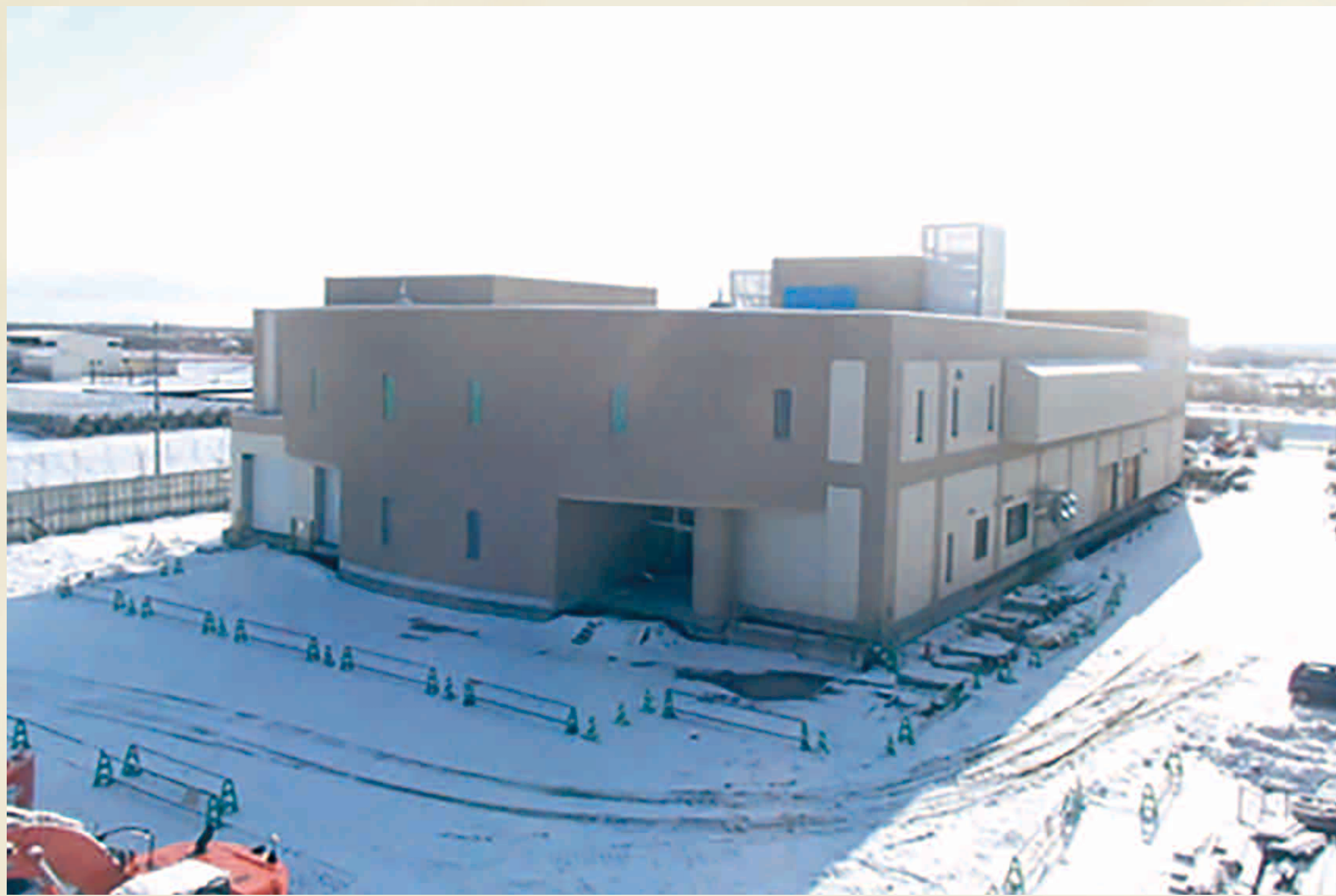
ひがしかりきうすい じょううんてんかいし ねん 東雁来雨水ポンプ場 運転開始(2018年) げんざい しょう じょうたいせい 現在の16か所のポンプ場体制へ
