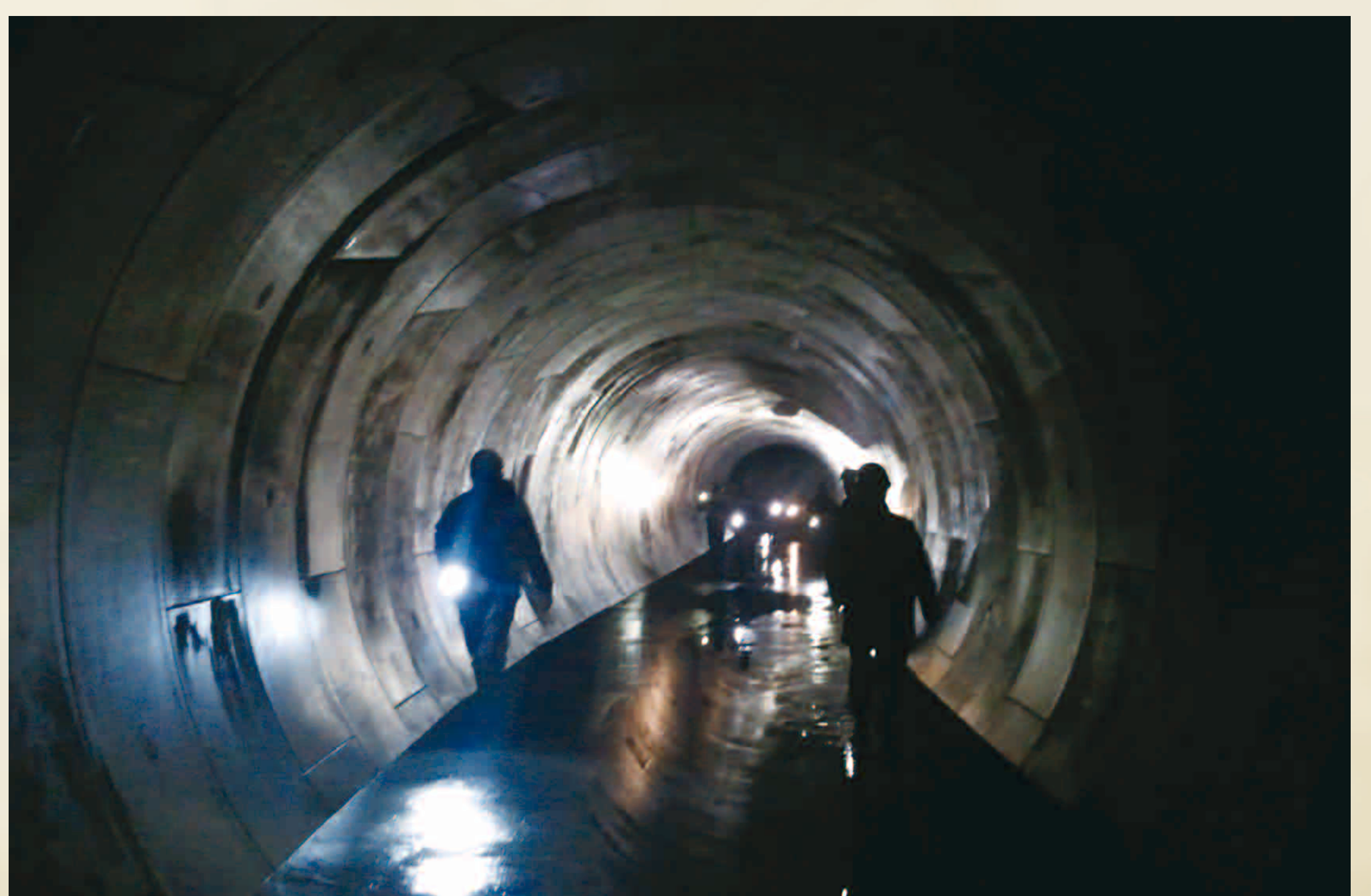
とよ ひら がわ う すい ちよりゅう かん きょうよう かい し ねん 豊平川雨水貯留管供用開始(2015年) かん せい ちよりゅう かん ない ある し みる む かい さい 完成した貯留管内を歩くイベントを市民向けに開催
