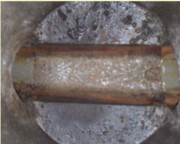
正常な公共ます
