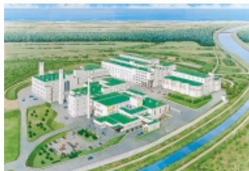
汚泥の集中処理施設としての「西部スラッジセンター」
