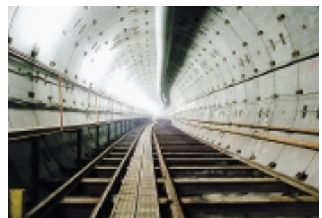
拡充管路整備
