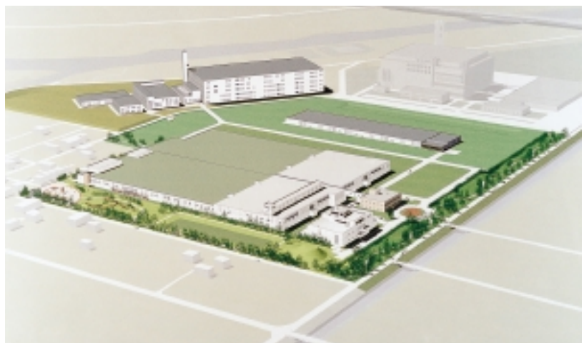
札幌市10番目の処理場となる「東部処理場」
