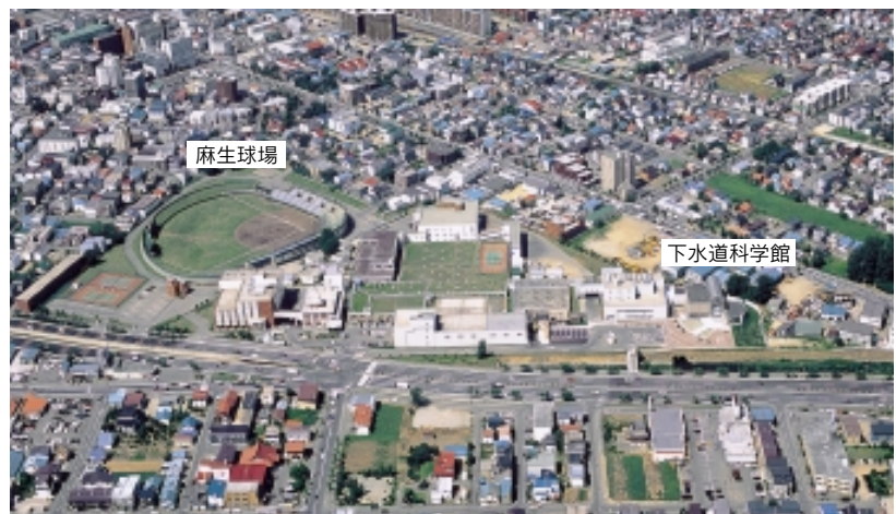
創成川処理場
