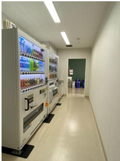
車いす使用者に配慮した自動販売機スペース (前面の通路幅: 約 130cm)
