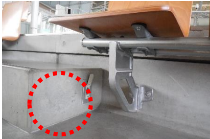
・観覧席の下部に設けられたヒアリングループ(磁気ループ)システムの補聴器用アンテナ線の接続端子
