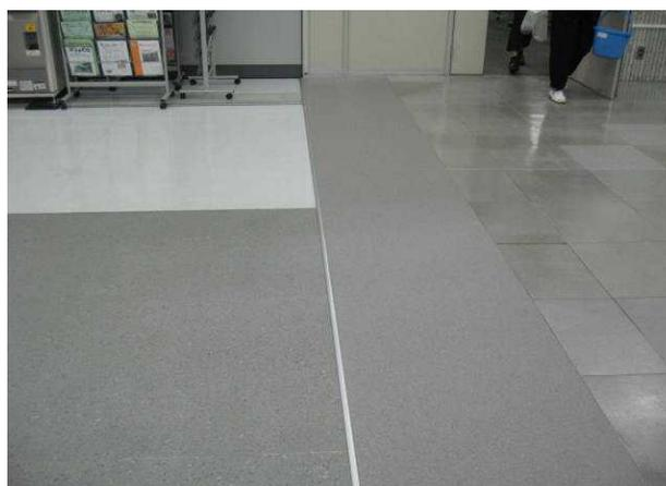
豊平区役所 1 階情報提供スペースのスロープについては、斜面が上下の床面と同系色の部材であることにより、傾斜していることが判別しにくい状態であったため、注意喚起の看板やセーフティコーンを設置していたところでした。また、通報を受ける以前から、斜面の部材の色を変更するとともに傾斜を緩やかにする改修を予定しており、既に改修を終えました。
