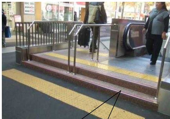
3丁目地下街出入口改修後の状況
