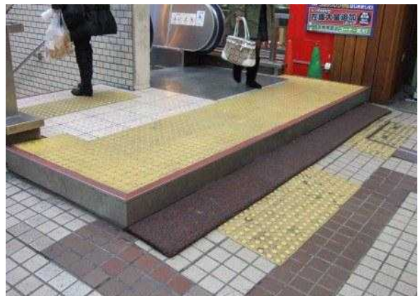
3丁目地下街出入口改修前の状況
